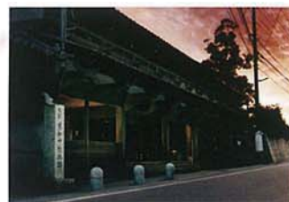
大角家住宅 旧和中散本舗
